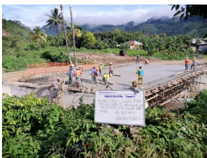
Montaje de superestructura Puente Saquixpec, Tramo II
