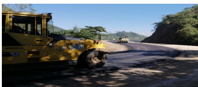
Colocación de asfalto, Tramo V
