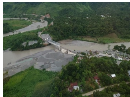
Vista aerea del puente sobre el río Copón, Tramo III
