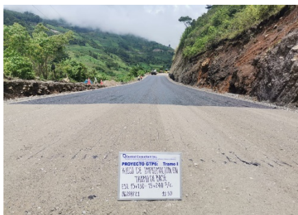
Proceso de imprimación de asfalto, Tramo I
