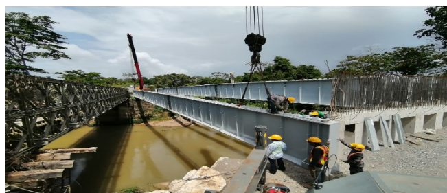
Montaje de superestructura Puente Trinitaria, Tramo IV
