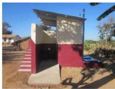
入口に設置されたスロープ
