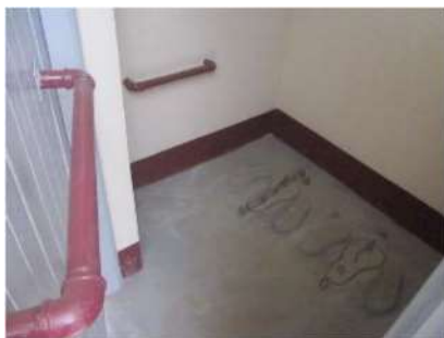
扉内側と壁に 設置された手すり
