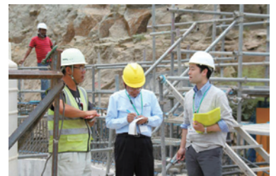
エチオピア経済にとって「重要すぎる橋」
