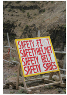
アフシ橋の工事現場に設置されていた注意喚起を促す看板
