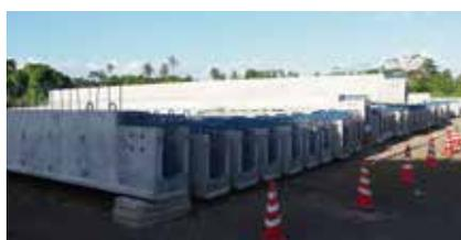
完成した新しい橋に使う橋桁
