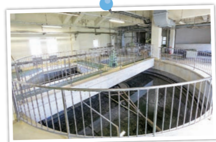
▲最終沈殿槽
