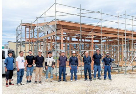
実習生が加工した住宅建築
