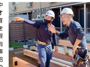
実習生が加工した住宅建築現場 日本の大工棟梁と
