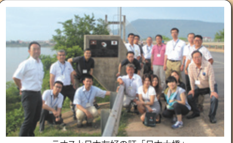
ラオスと日本友好の証「日本大橋」(日本の援助で建設された橋)
