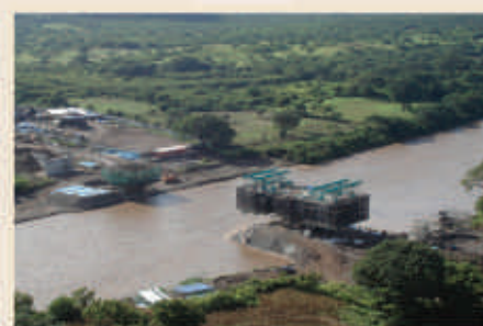
Puente de la Amistad del Japón y Centroamérica (en construcción), Valle
