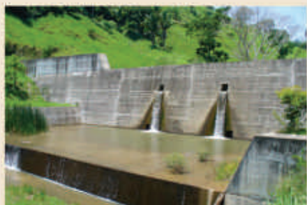
Control de Inundaciones y Sedimentos en el Río Choloma, Cortés
