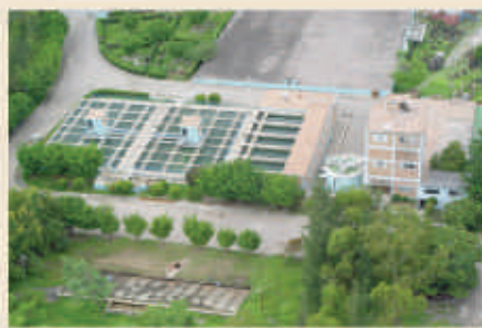
Rehabilitación de Tuberías del Sistema de Agua Potable, Tegucigalpa
