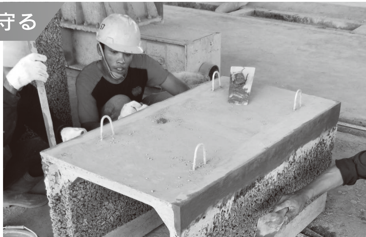
インドネシアの工場にて ポラスコンクリートの試作製造風景
