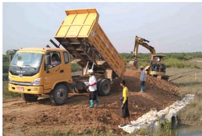
[上]開発が進むゾーンAの様子。送電線が整備され、大型トラックが頻繁に行き交う [下]ティラワ港につながるアプローチ道路も着々と工事が進んでいる
