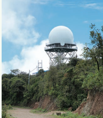
バテダダ山の頂上に作られた真新しい航空路監視レーダー。カトマンズ周辺の山々を越え、国土の7割をカバーする
