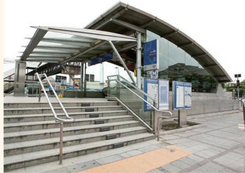
地下鉄ブルーライン・パンスー駅の入口。洪水対策のため入口が道路面よりも高く設定されているのが分かる
