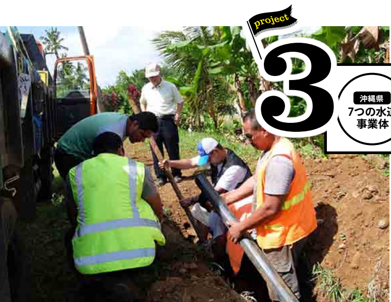
漏水箇所をつきとめて水道管を交換する
