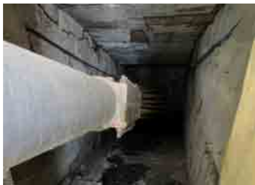
トンテイ橋のアンカー部分。定着部付近に滞水が確認された。トンテイ橋のアンカーには腐食は見られないが、今後を考え、溜まった水を排出できるような対策が必要と提案した。
