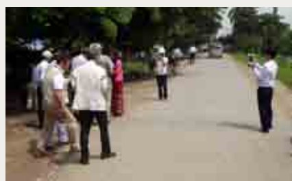
試験舗装した道。この後、イエガレ村では近隣の町まで同品質の舗装工事を行い、それまでは1時間かかっていたところ、わずか20分で行けるようになった。村は大いに活気づき、町に昇格した。
