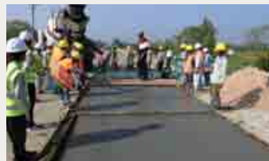
今年2月には、コンクリートの舗装道路が完成した。今はマニュアル作成が佳境に入っている。
