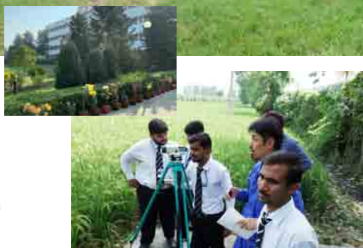
ムザファルナガル市の大学では学生寮の生活排水をTSSで処理する計画が進んでいる。測量は土木部の学生が授業の一環として手伝った。施工に関するアドバイスをするのはTSS事業部長の松本安弘さん(写真右中)。
