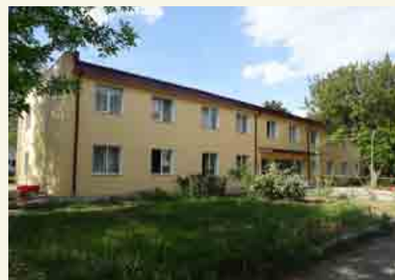
日本の協力によって整備されたシェルター。
