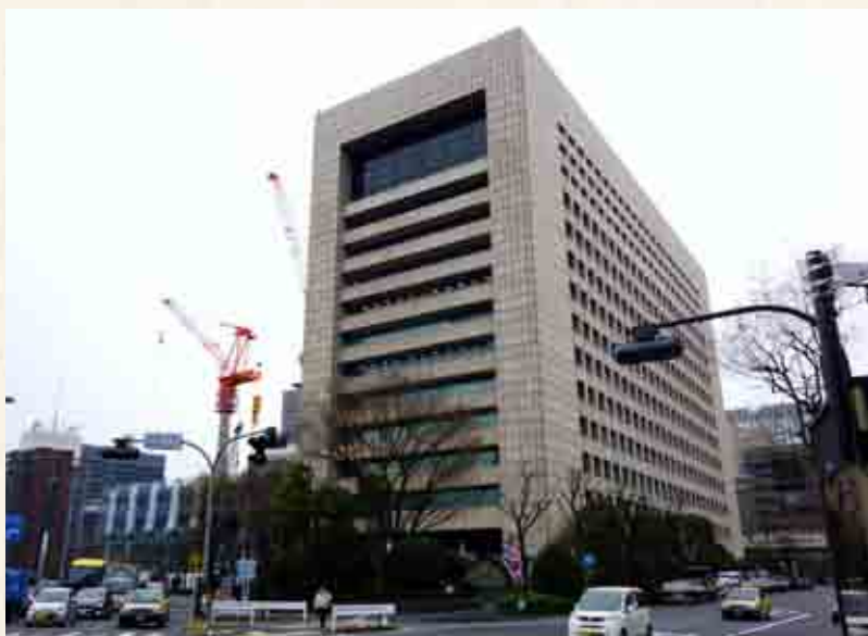
移転先の竹橋合同ビル(東京都千代田区大手町1-4-1)。
