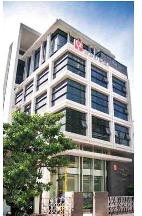
2013年に完成したKAIZEN吉田スクールの校舎(ホーチミン)。地上7階、地下1階建てのビルで約2,000人が学ぶ。校名の「KAIZEN(改善)」には、ベトナムの人の働き方と社会を改善したいとの思いが込められている。
