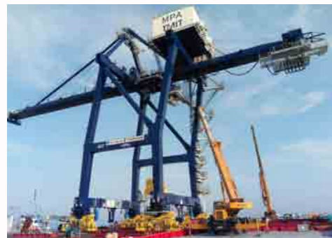
免震装置付きガントリークレーン。
