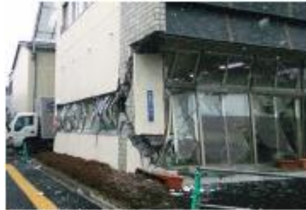
地震により壊されたビル (岩手県宮古市)
