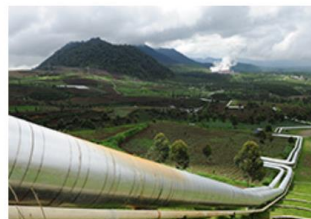
モデル・サイトである出力227MWのWayang Windu地熱発電所地区
