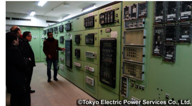
変電所内リレーシステム視察の様子 (写真提供: 東電設計株式会社)
