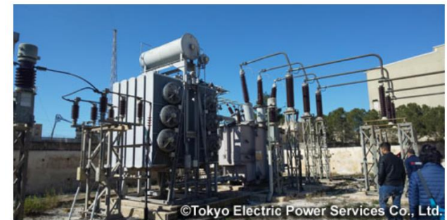
イルビド変電所風景 (写真提供: 東電設計株式会社)
