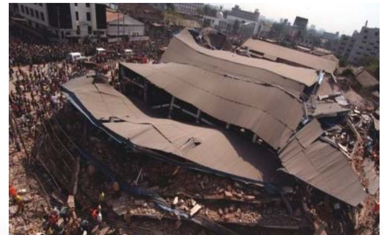
バ国での地震によらない崩壊事例
