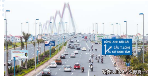
ニャットタン橋と連絡道路
