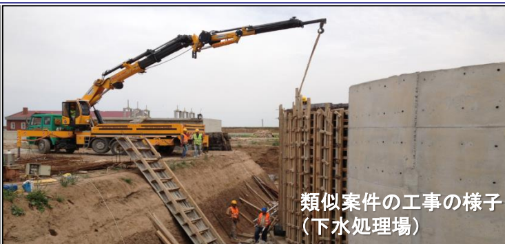
類似案件の工事の様子 (下水処理場)
