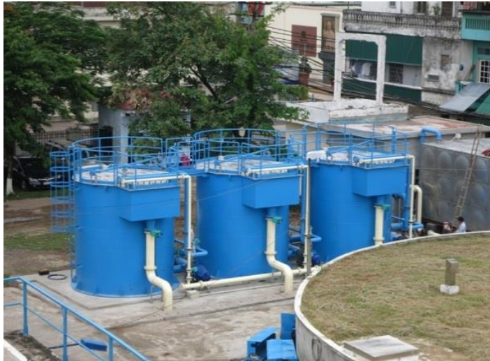
導入された水処理装置(株式会社ナガオカ)
