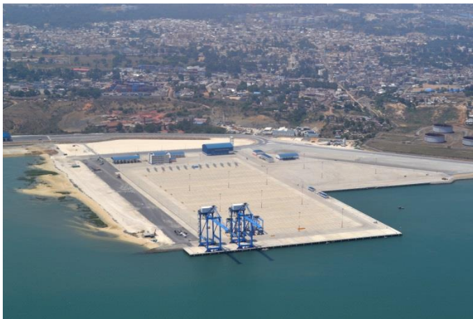
写真左上及び左下：円借款で建設されたモンバサ港のコンテナターミナル。(写真提供：東洋建設)
