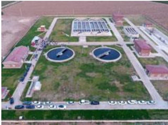
本事業に先行して実施した類似事業で整備した下水処理場 (シリア国境ハタイ県、2017年完成) (写真：JICA)
