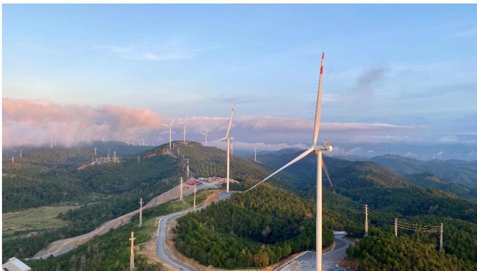
融資先のプロジェクトカンパニーにより建設された風力発電設備(写真提供:レノバ社)
