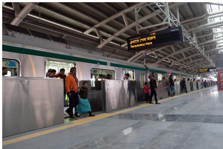
ホームドアが設置されている駅のホーム(写真:DMTCL)
