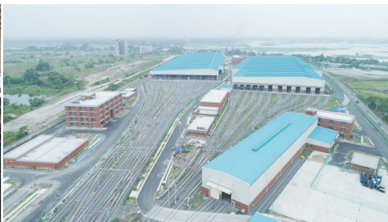
車両基地(写真: 日本工営)
