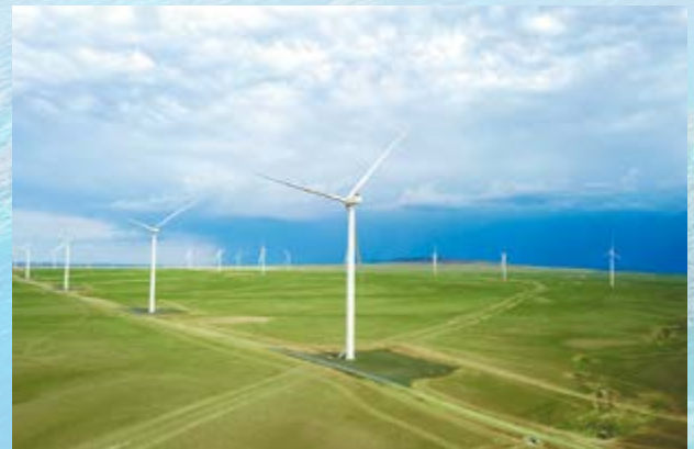
モンゴルで2番目の自然エネルギープロジェクトとして民間事業者により実施されるツェツィー風力発電所に、欧州復興開発銀行と協調して海外投融資による支援を実施
