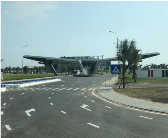
写真：ベトナムの自動車会社「VinFast」が工場を設置
