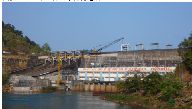
図表15. ナムグム第一水力発電所
