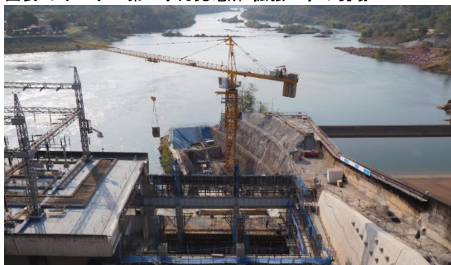
図表16. ナムグム第一水力発電所: 拡張工事の現場
