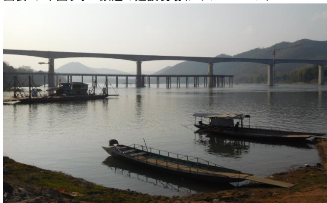
図表 18. 中国ラオス鉄道の建設現場(ルアンパバーン)
