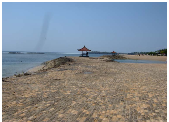
図表 13: バリ島の海岸保全対策現場 (円借款事業)
