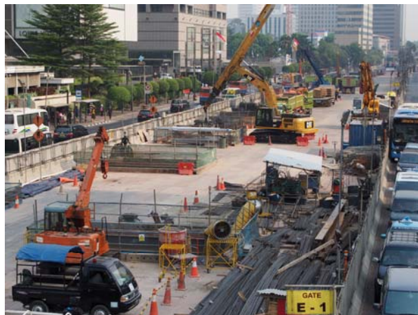
■写真1: 工事現場
