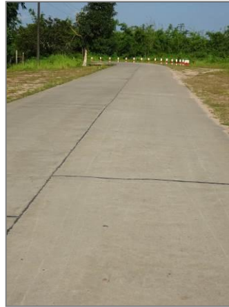
図表 20 : 整備されたコンクリート舗装の道路
