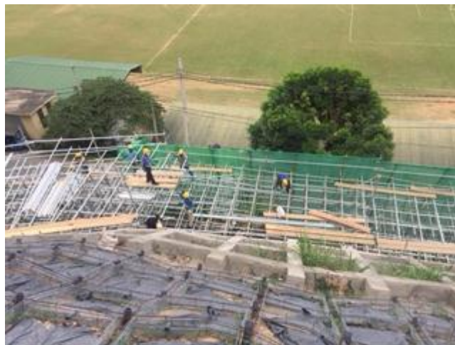
写真2：金網を施工後にコンクリートを充填、奥は道路とグラウンド
