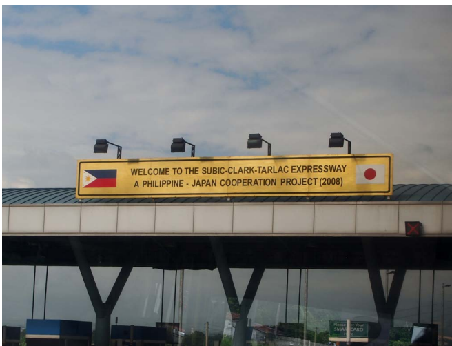
■写真1: SUBIC-CLARK-TARLAC EXPRESSWAYの料金所
