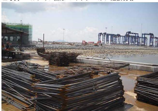
■写真12: カイメップ国際コンテナターミナル建設現場
