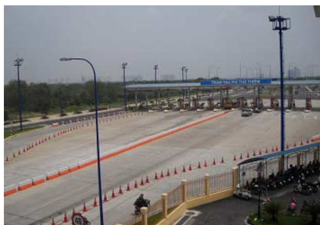
■写真6: トゥーティエムトンネルの料金所
