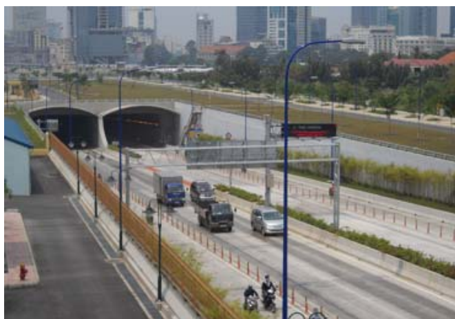
■写真5: トゥーティエムトンネル入り口
