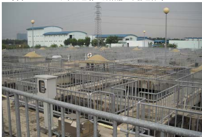
■写真7: ビンフン下水処理場の沈殿槽から管理棟等
