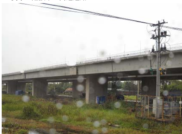
■写真9: 建設中の高速道路
