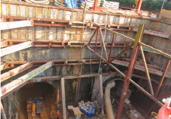
■ 図表 36 : デリーメトロのフェーズⅢ建設現場
