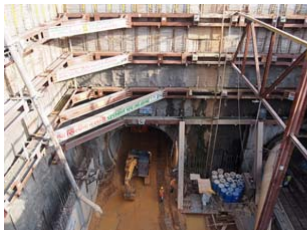
■写真 3: フェーズ 3 の工事現場
