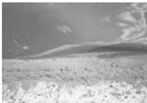
法 ( aerated lagoon ) を採用した下水処理場である。しかし、実質的には安定化池 ( waste stabilization pond ) と同じ外観であった<sup>注16)</sup>。水面はアオコ ( 主にランソウ類の Microcystis 属 ) のために緑色のペンキを流したような状態 ( 写真 - 1 ) で、廃水中の有機物分解で生じた窒素・リンなどの栄養塩が熱帯の豊富な日射を受け、植物プランクトンが大増殖していることがわかる。ここでは、市役所が池内での漁獲を規制する政策を採っていた。
