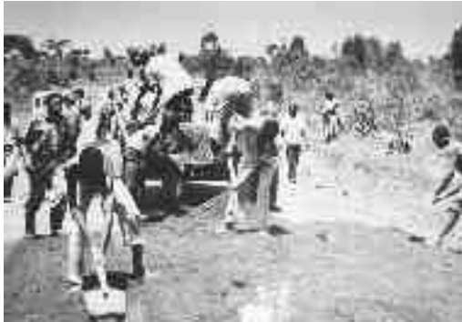
写真 - 1 道路建設
