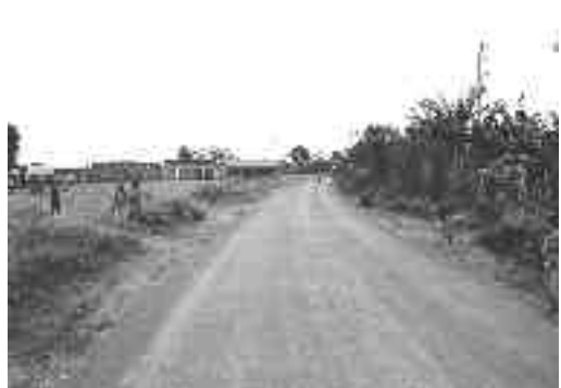
写真 - 4 道路建設から数年後
