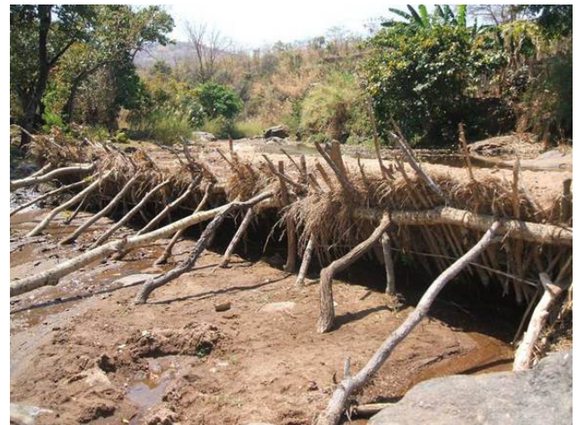
マラウイ全土で普及しつつあるテンポラリー灌漑。木材や草など地場で入手できる材料を用いて建設される。
