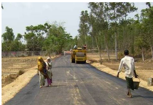
LGEDによって建設中の道路 写真:LGED
