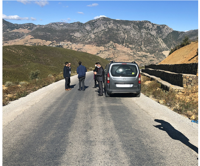
整備後のモロッコ地方道路
