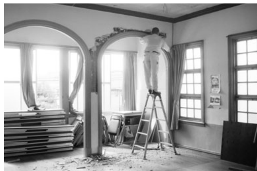
写真8 解体中の豊中クラブ自治会館の2階
