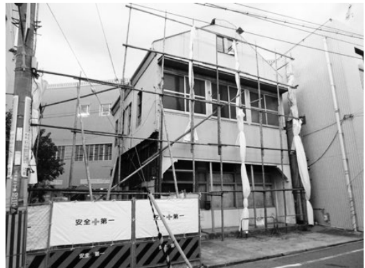
写真10 解体中の豊中クラブ自治会館の外観
