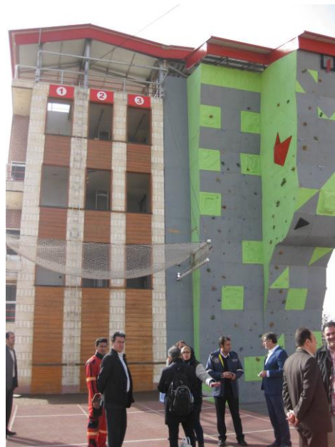
帰国研修員が建設した研修施設
