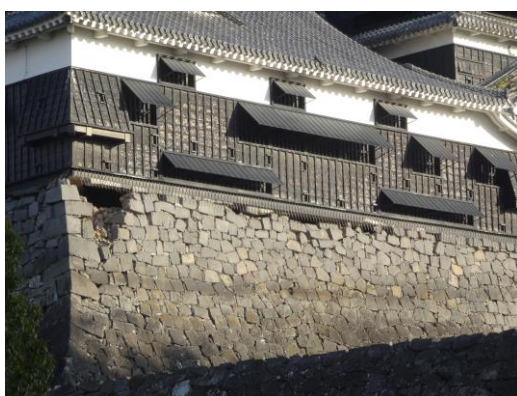
石垣の一部が崩れた熊本城天守閣
