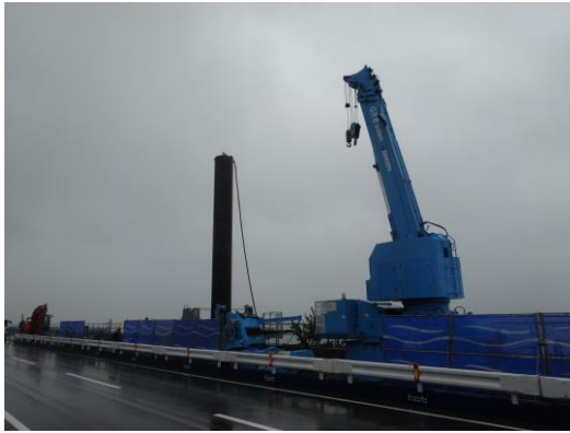
(株) 技研製作所 防潮堤工事現場視察
