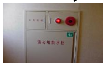
Зүүн: Яаралтай дуудлагын утас Баруун: Дохиоллын товчлуур Доод: Галын хоолой
