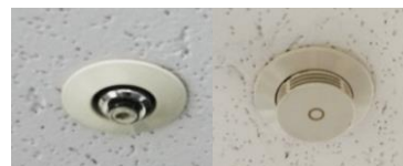
Слева: Спринклер Справа: Датчик тепла и дыма
