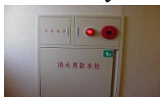
Слева: Аварийный телефон Справа: Тревожная кнопка Внизу: Пожарный шланг
